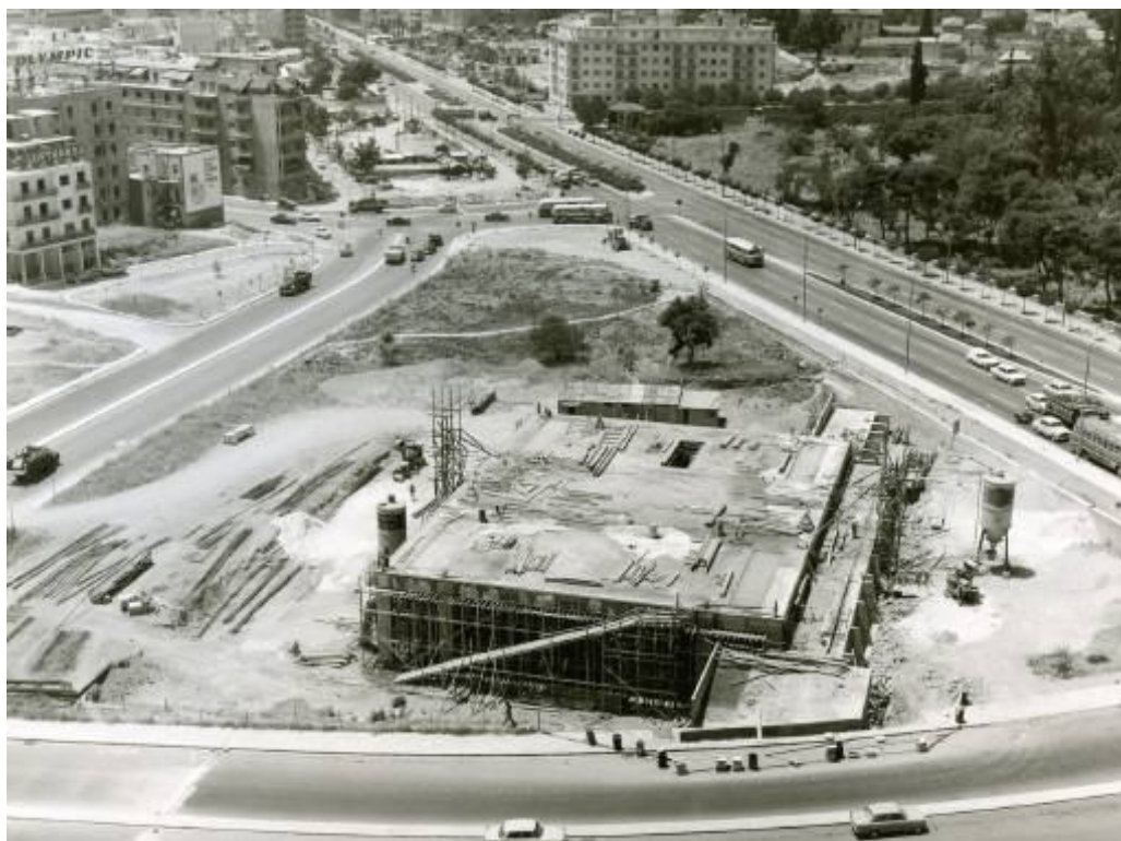
Το Α' τμήμα της Εθνικής Πινακοθήκης στο στάδιο της κατασκευής
