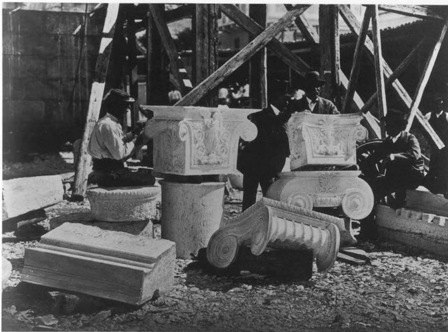
Εικ. 13. Η κατασκευή της Ακαδημίας των Αθηνών: Λιθοξόοι εν ώρα εργασίας. Φωτογραφία του Πέτρου Μωραΐτη, περί τα 1870. Βιέννη, τμήμα χαρακτικών της Ακαδημίας Καλών Τεχνών.
