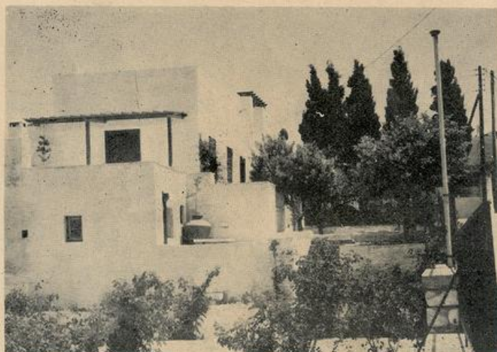
Τὸ σπίτι τοῦ Χαλεπᾶ. Γενικὴ ἀποψή του σήμερα, ἔπειτ' ἀπὸ τὶς ἐργασίες.
